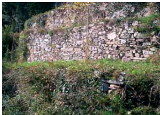
Fig. 3 - Terrazzamenti nella frazione Oggiogno villa "Il Sasso"
