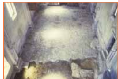
Fig. 33-34. Foto degli scavi all'interno del Santuario.
