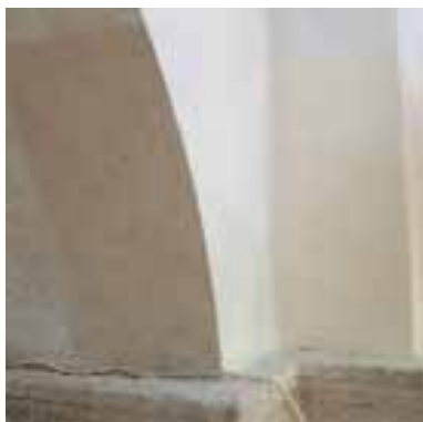
1. I lavori sulle pareti esterne del santuario
